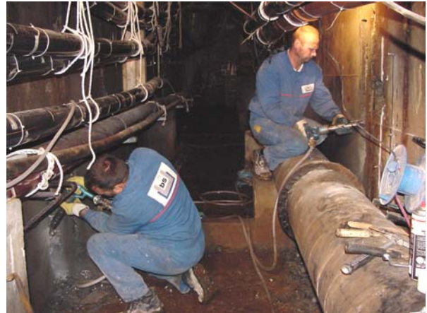
Abb. 8: Räumliche Verhältnisse im Kabeldüker / Stemmarbeiten
