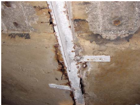
Abb.: 4: Stahlaschenabdeckung
