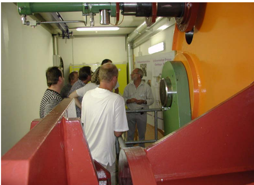
Besichtigung des Oberhauptes der Großschiffahrtsschleuse
