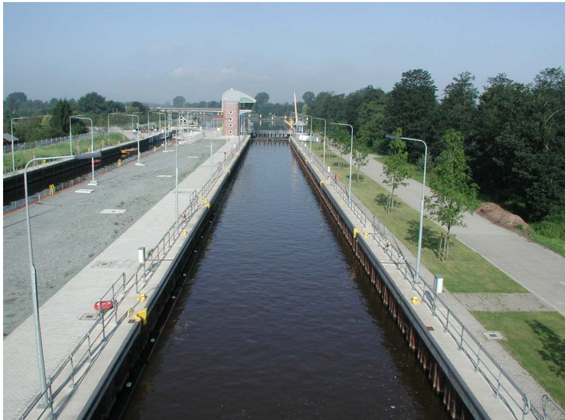
Neue Großschiffahrtsschleuse Bremen
