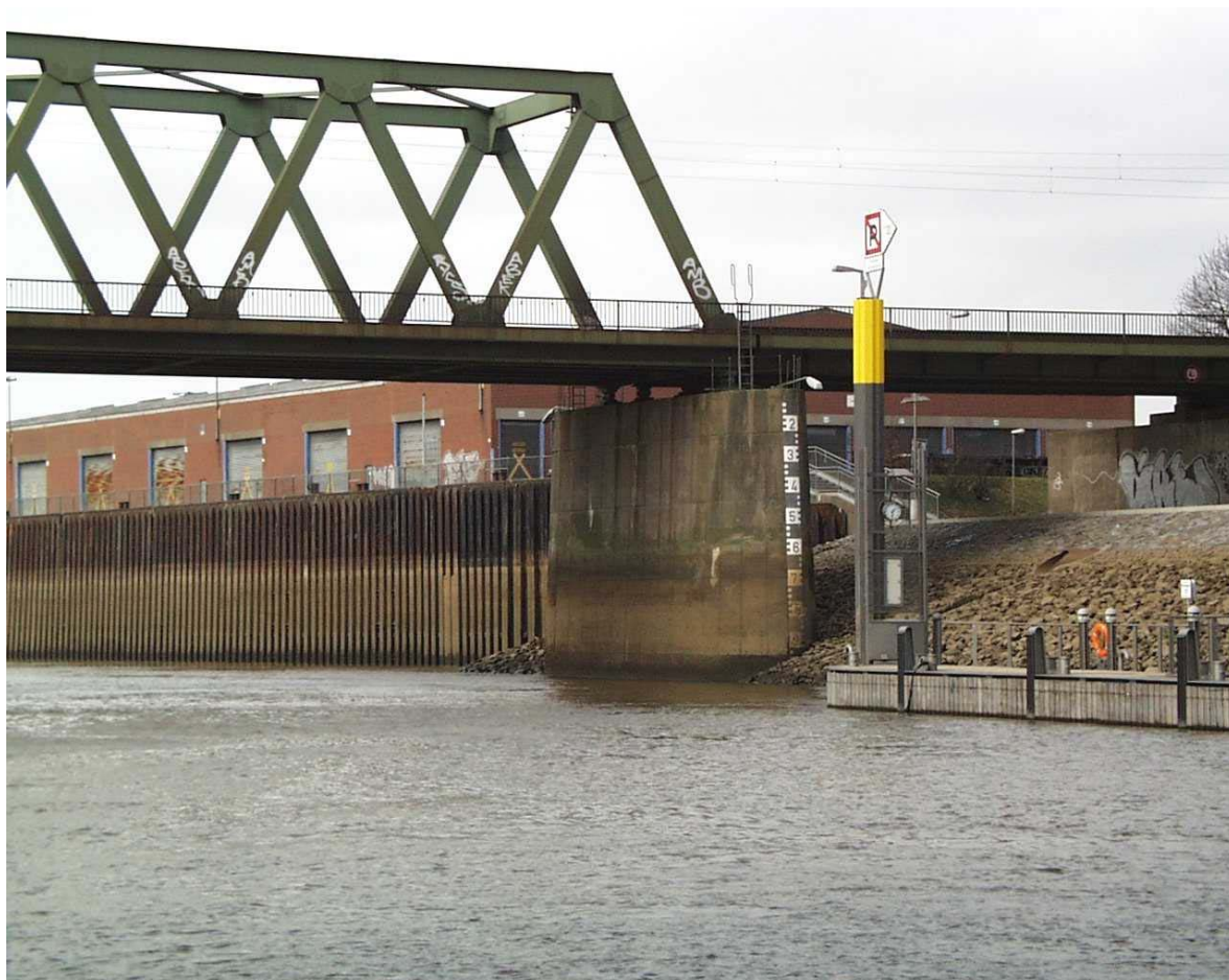
Abb. 12: Eisenbahnbrücke Bremen, Brückenpegel oberhalb (Anleger nicht belegt)
