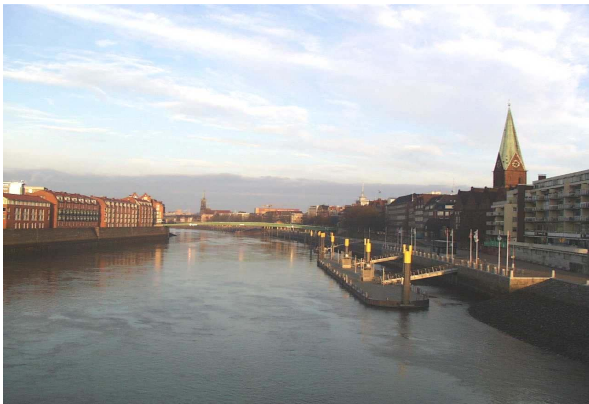
Abb. 2: Ausgebaute Schlachte mit Anlagen ohne Schiffsbelegung
