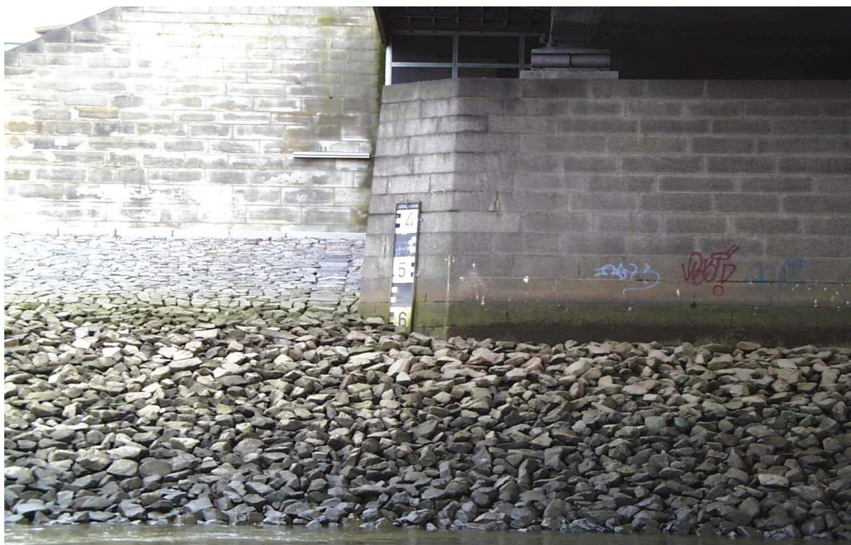
Abb. 13: Bürgermeister-Smidt-Brücke, Brückenpegel unterhalb
