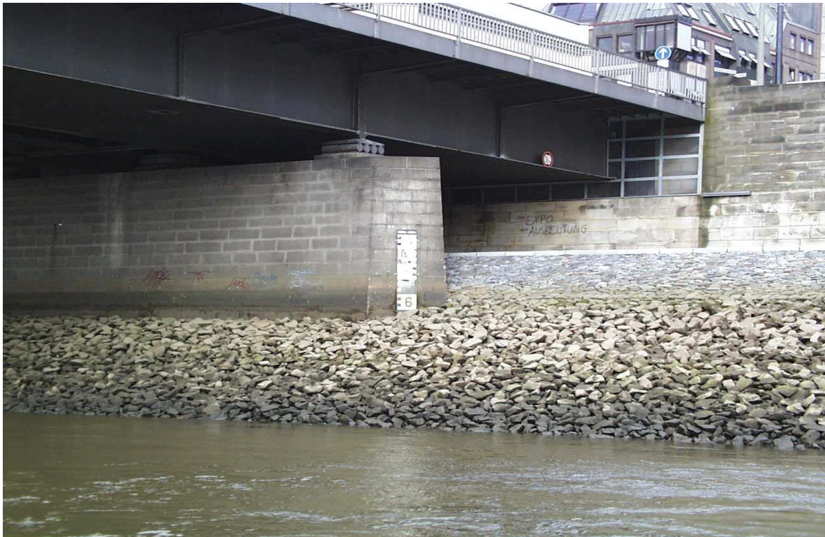
Abb.14: Bürgermeister-Smidt-Brücke, Brüchenpegel oberhalb
