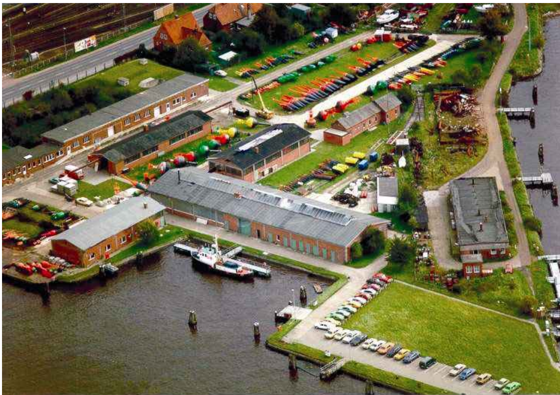
Abb. 5: Luftaufnahme des Bauhofes um 1980. Die Aufnahme zeigt den Bauhof vor dem Umbau.
