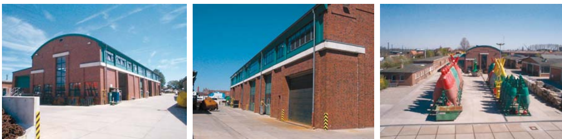
Abb. 6,7 und 8: Ansichten der neuen Tonnenhalle
