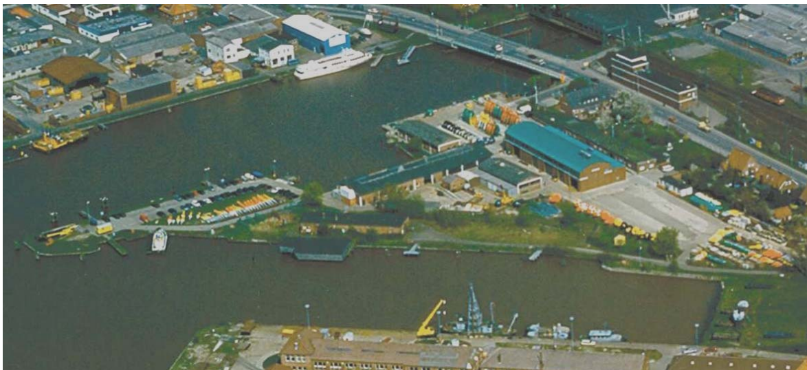
Abb. 10: Luftaufnahme des Bauhofes aus dem Jahr 2000: In der Mitte des Bauhofes erkennt man die neue Tonnenhalle mit dem grünen Dach. Die neue Straßenbrücke über den alten Binnenhafen und die Südumgehung der Stadt begrenzen das Bauhofsgelände im Norden; im Süden befindet sich der "Alte Liegehafen" der ehemaligen Staatswerft.
