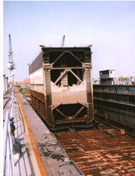
Abb. 2: Schiebetor im Trockendock
