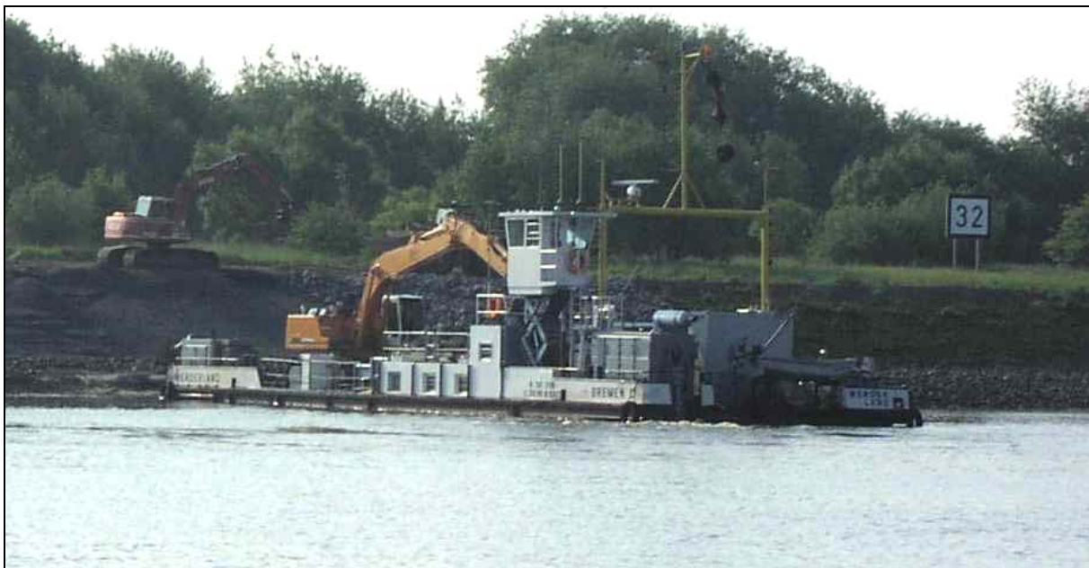
Abb. 1: Deckwerkarbeiten mit dem SG "Harrier-Sand" bei Unterweser-km 32, rechtes Ufer
