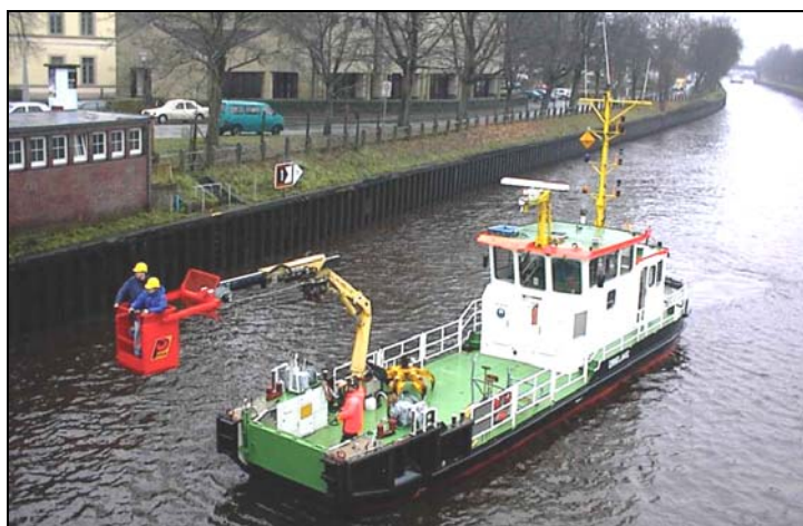
Abb. 2: MS "Drielake" beim Einsatz mit Arbeitskorb in der Stadtstrecke Oldenburg
