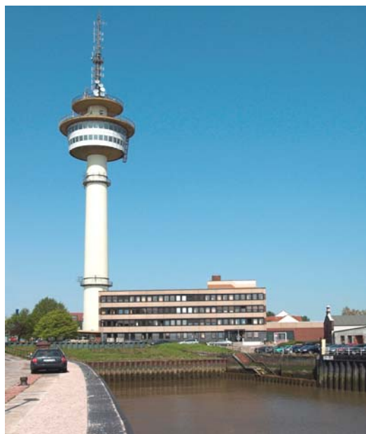
Bild 5: WSA Bremerhaven mit Richtfunkurm
