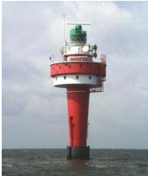
Bild 3: Leuchtturm ALTE WESER
