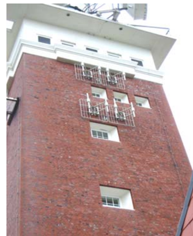
Abb. 7: AIS-Antennen am Leuchtturm Helgoland
