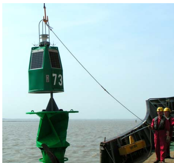
Abb. 18: Montage des SKA mittels Schnellkupplung
