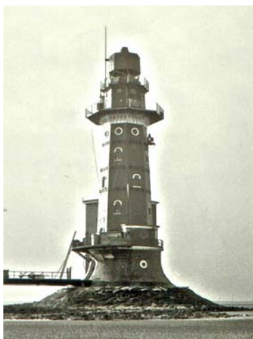
... und nach dem Umbau
