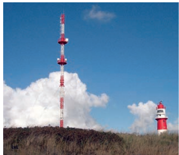
Abb. 3: Richtfunk Leuchtturm – Borkum
