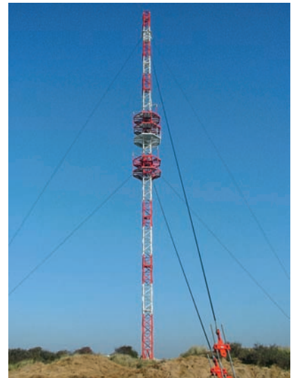
Abb. 11: Ansicht des neuen Funkmastes
